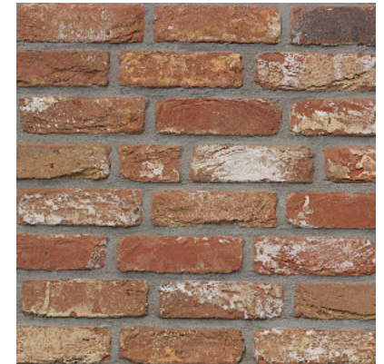
S1-00026-01 Backstein Gewölbe
