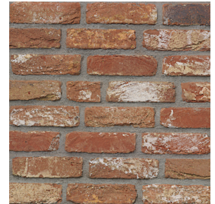
S1-00026-01 Backstein Gewölbe
