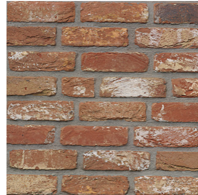
S1-00026-01 Backstein Gewölbe
